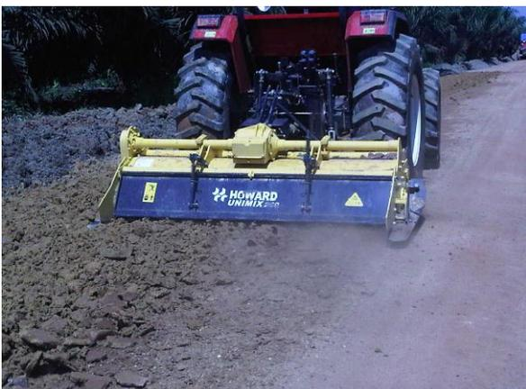
Gambar 7. Jalan digaruk dengan menggunakan rotopator
