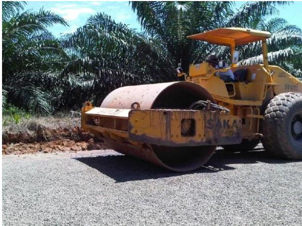
Gambar 11. Pemadatan kembali dengan menggunakan *compactor*
