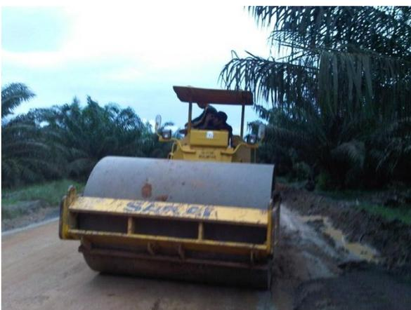
Gambar 3. Pemadatan badan jalan menggunakan *compactor*
