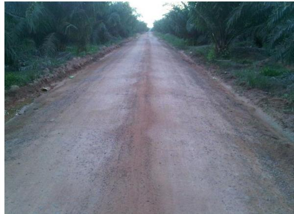
Gambar 4. Hasil akhir pengerasan jalan menggunakan laterit
