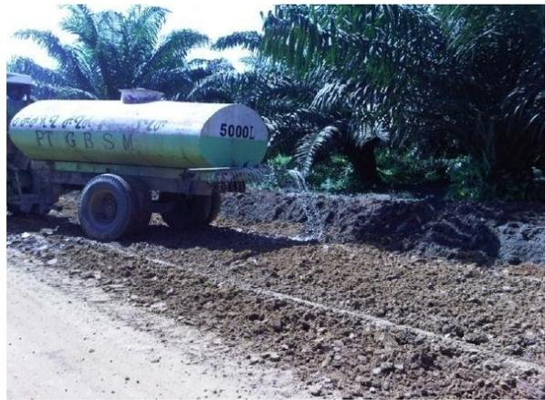
Gambar 8. Penyiraman jalan dengan menggunakan Probase TX-85
