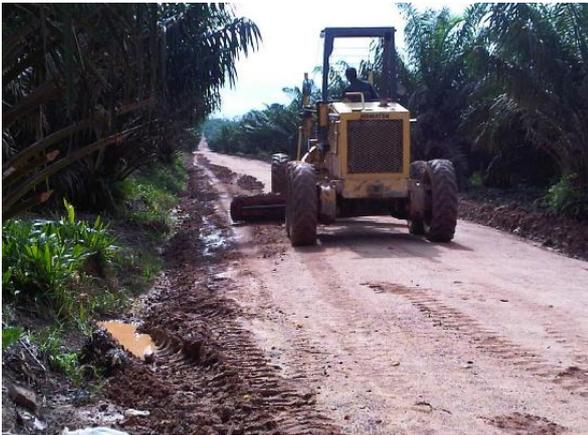
Gambar 6. Pembentukan jalan dengan menggunakan *grader*
