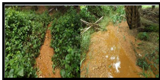
Gambar 4. Pendangkalan saluran air dan pengikisan tanah sebagai akibat dari erosi alur pada jalan koleksi
